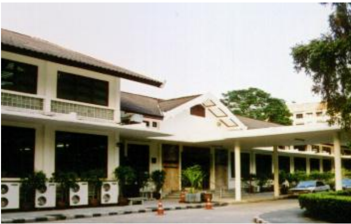
อาคาร 1 (อาคารพูนทรัพย์ นพวงศ์ ณ อยุธยา)
